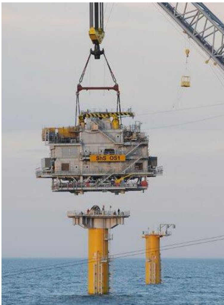
Fotografia 5. Montaż platformy stacji elektroenergetycznej na fundamencie monopalowym
